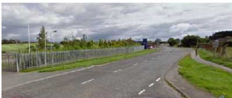
NW looking SE Millvale Rd
